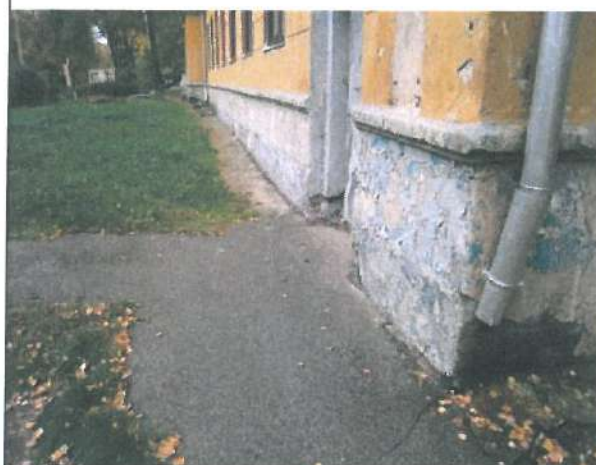
4.1.2. un 4.1.3. att. Ēkas pamatu betona/dzelzsbetona aizsargapmales
