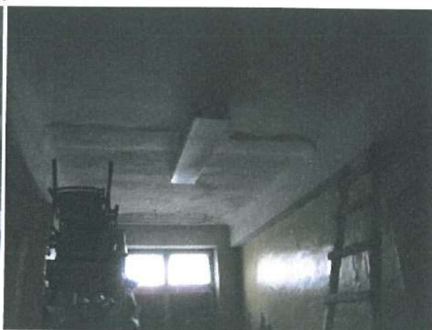
4.6.1. un 4.6.2. att. Dz-betona paneļu pārsegums
