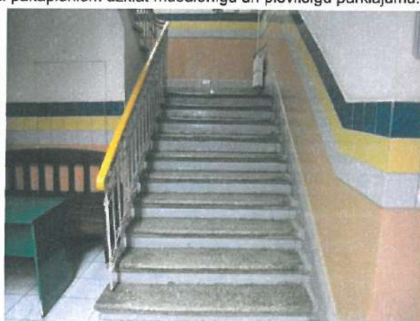
4.10.2. att. Dzelzsbetona konstrukcijas kāpnes
