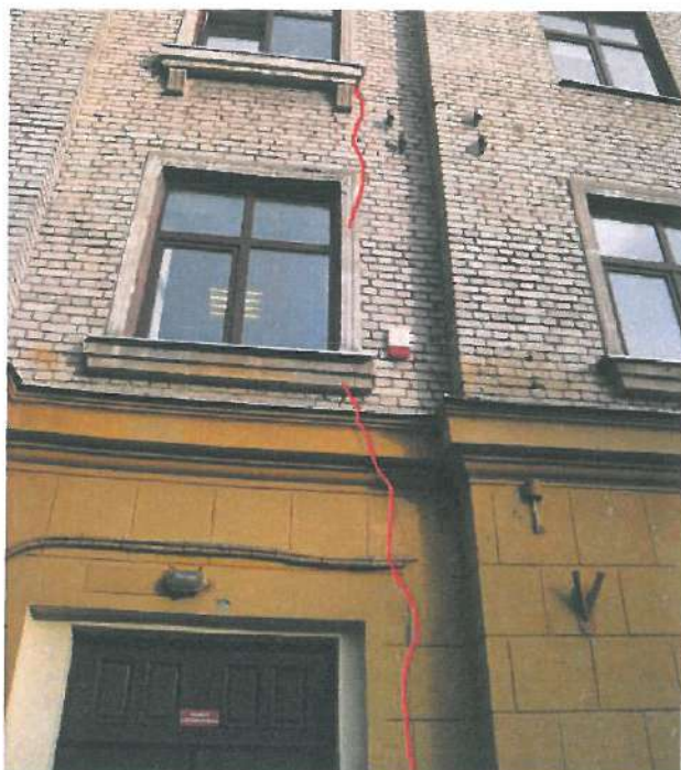
4.2.3. un 4.2.4. att. Plaisas ēkas ārsienās (ziemeļu puses fasādē)
