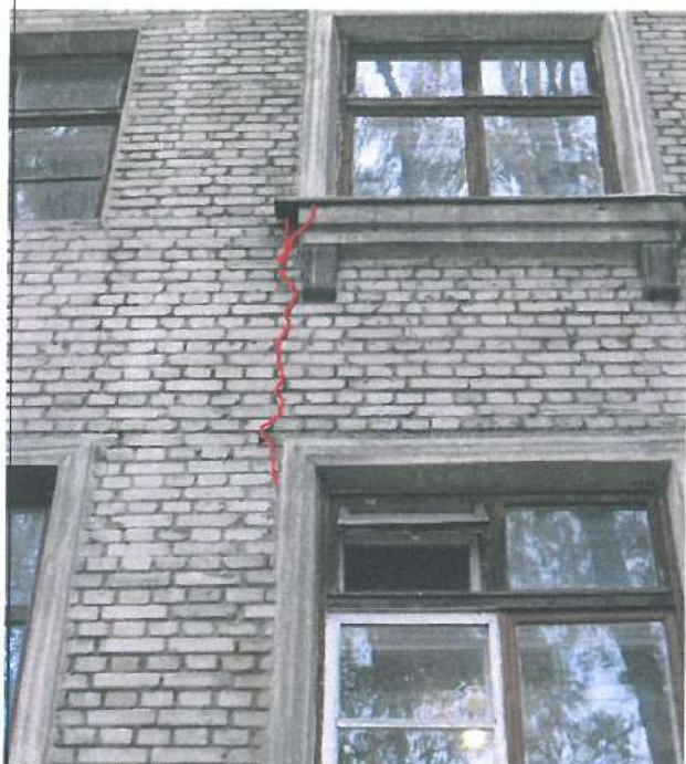
4.2.1. un 4.2.2. att. Plaisas ēkas ārsienās (ziemeļu puses fasādē)
