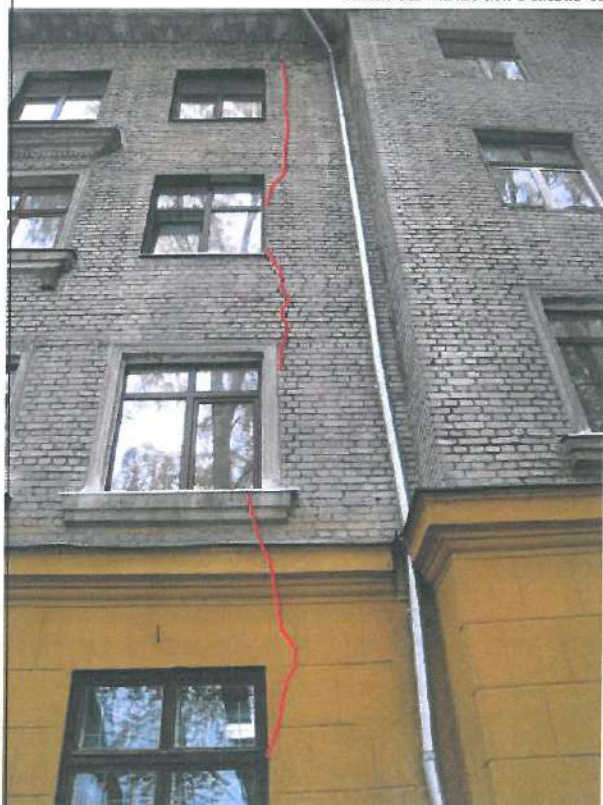
4.2.3. un 4.2.4. att. Plaisas ēkas ārsienās (ziemeļu puses fasādē)
