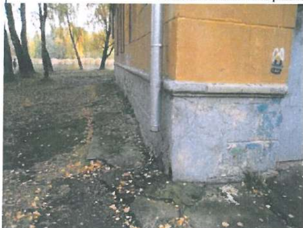
4.1.4. un 4.1.5. att. Ēkas pamatu betona/dzelzsbetona aizsargapmales
