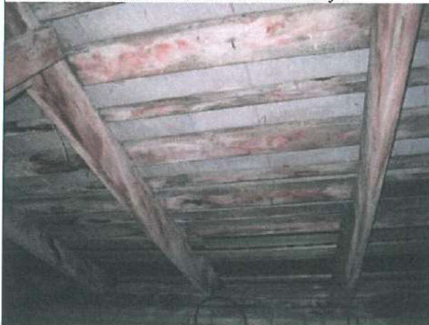
4.8.3. att. Kondensāta radīti mitruma pleķi
