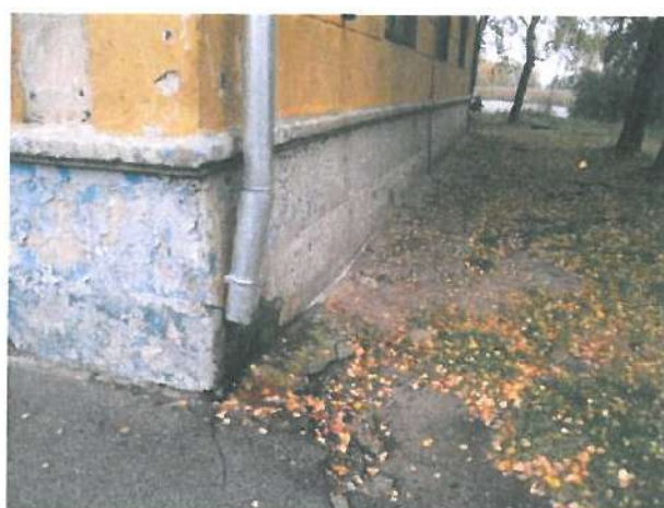
4.1.2. un 4.1.3. att. Ēkas pamatu betona/dzelzsbetona aizsargapmales
