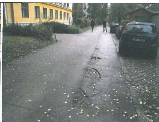
3.1.1. un 3.1.2. att. Asfaltbetona segums ar lokāliem bojājumiem
