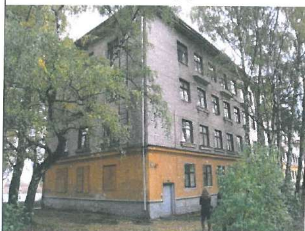
4.19.9. Ēkas rietumu puses fasāde
