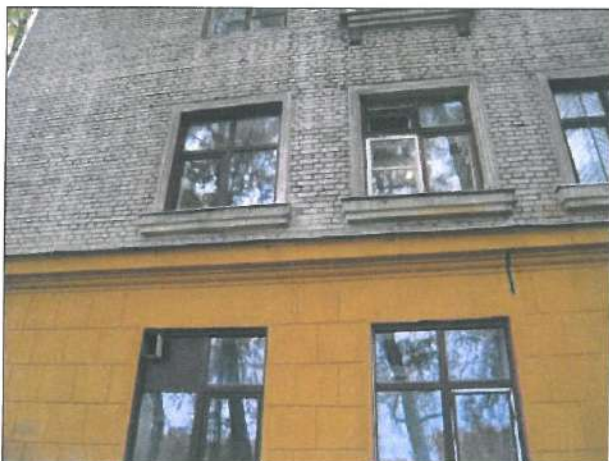
4.13.1. un 4.13.2. att. Koka un PVC konstrukcijas logi
