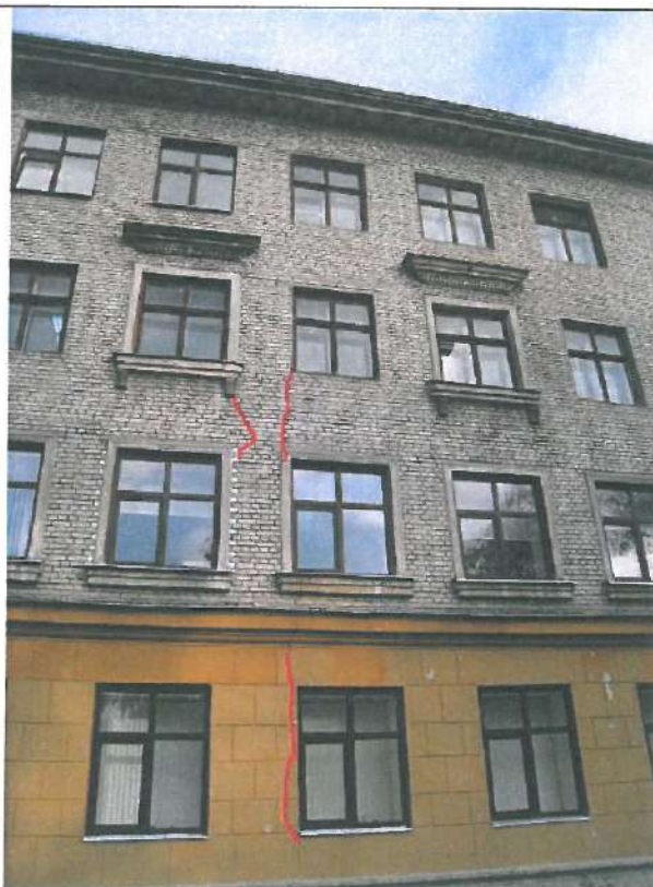
4.2.5. un 4.2.6. att. Plaisas ēkas ārīnās (dienvidu puses fasādē)
