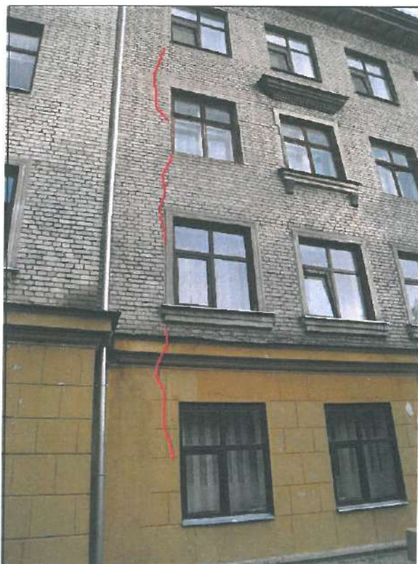
4.2.5. un 4.2.6. att. Plaisas ēkas ārīnās (dienvidu puses fasādē)
