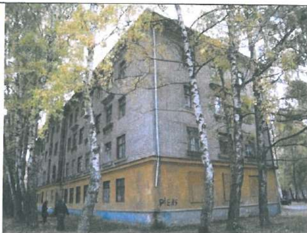
4.19.8. Ēkas rietumu puses fasāde
