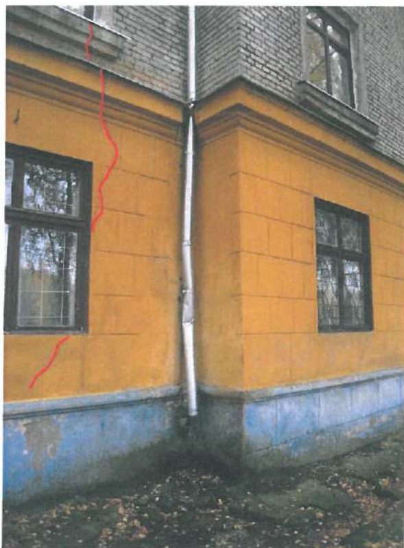
4.2.1. un 4.2.2. att. Plaisas ēkas ārsienās (ziemeļu puses fasādē)
