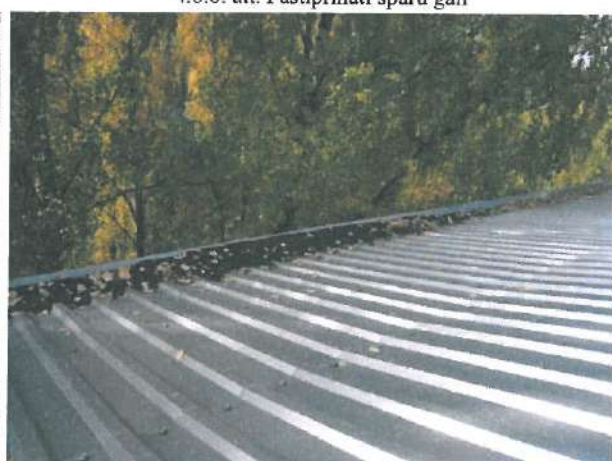
4.8.8. att. Lapu aizsērējumi uz jumta seguma
