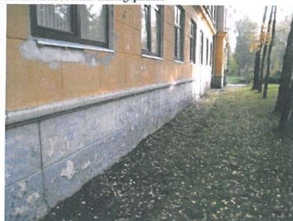
4.1.4. un 4.1.5. att. Ēkas pamatu betona/dzelzsbetona aizsargapmales
